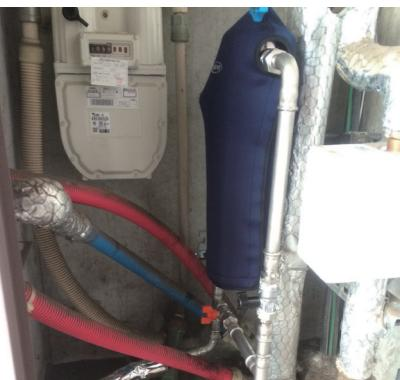
マンションのパイプスペースに設置するため、スペースの広さなど環境に応じて配管ルートを設計する必要があります。これは一戸建てでも同様に、設置後は蛇口から出る水の塩素が除去され浄水されていることを「DPD試験薬」（残留塩素測定試薬）でチェックし、設置完了となります。
