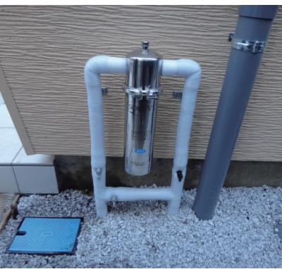
設置工事は、まず水道メーターの周りに埋められている給水本管を掘り出し切断してバイパスを通してそれをソリューヴの設置位置まで立ち上げて接続します。その後ソリューヴを建物の壁面に固定し、掘り起した土を埋めて完了です。屋外に設置するため、環境に応じて保温対策、紫外線対策が必要です。
